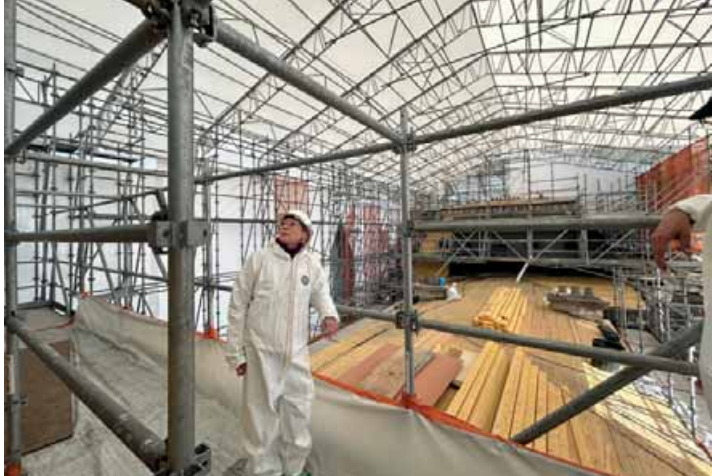
Plusieurs phases de travaux doivent se succéder sur l'Hôtel de Ville d'Arras. L'énorme échafaudage sera déplacé plusieurs fois au cours du chantier © Julien Melin - Ville d'Arras
