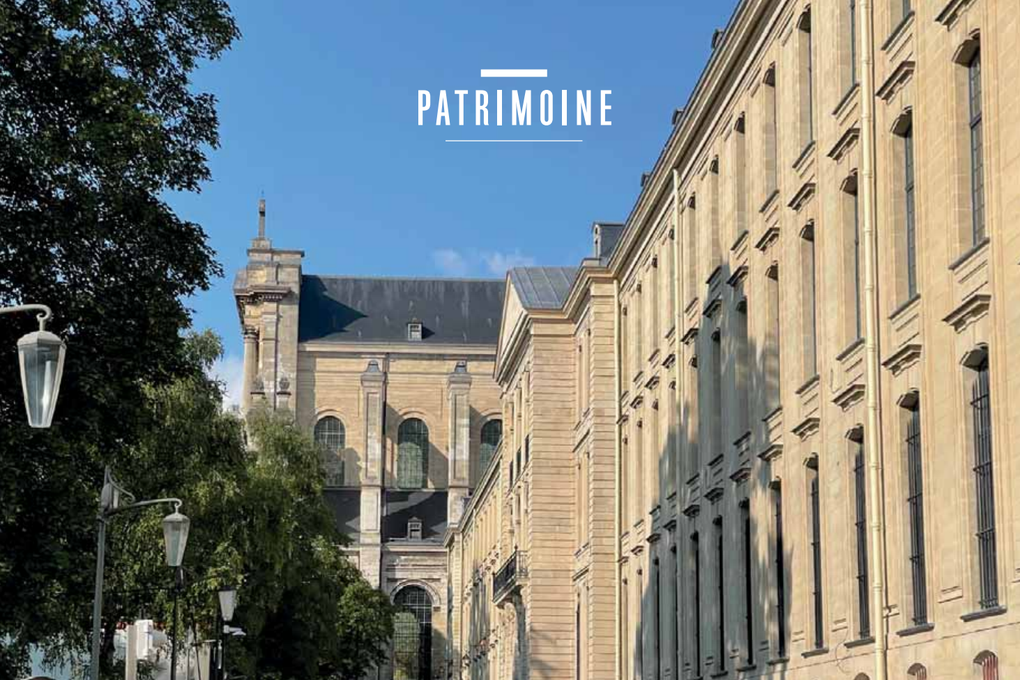
Façade rénovée de l'Abbaye Saint-Vaast, côté jardin de la Légion d'Honneur (Arras) © Denis Cordonnier
